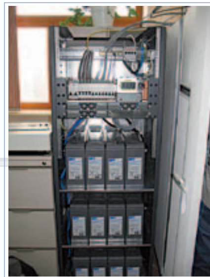
Рис. 15 Смонтированная батарея A412/120FT
